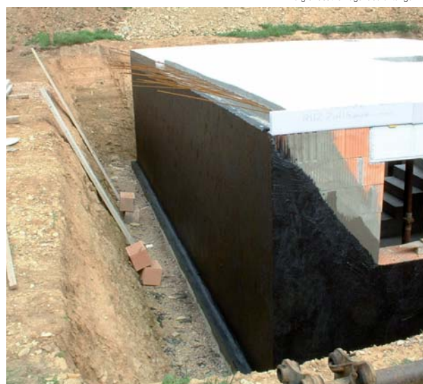
Uszczelnienie zewnętrznej ściany piwnicy z betonu za pomocą PCI Pecimor® 2K. Łatwy w nanoszeniu dzięki wypełnieniu polistyrenowemu.
